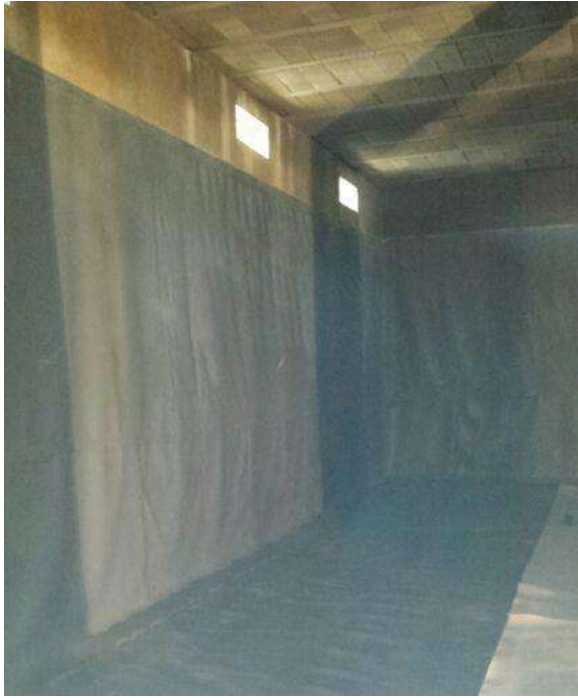
GEOTEXTIL PILARES
