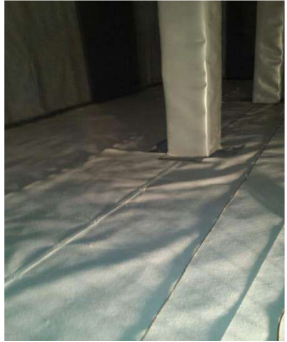
GEOTEXTIL PILARES
