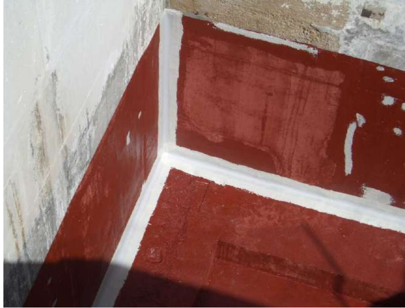
TRATAMIENTO DE JUNTAS
