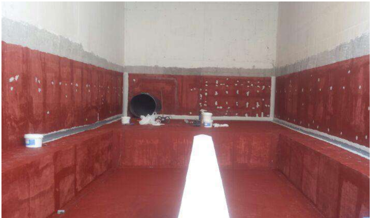
TRATAMIENTO DE JUNTAS
