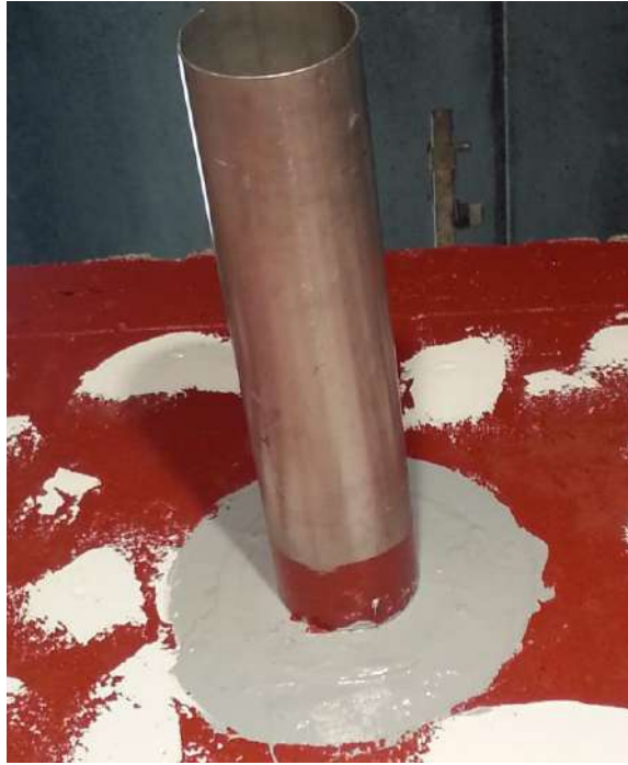
ENMASILLADO DE FISURAS
