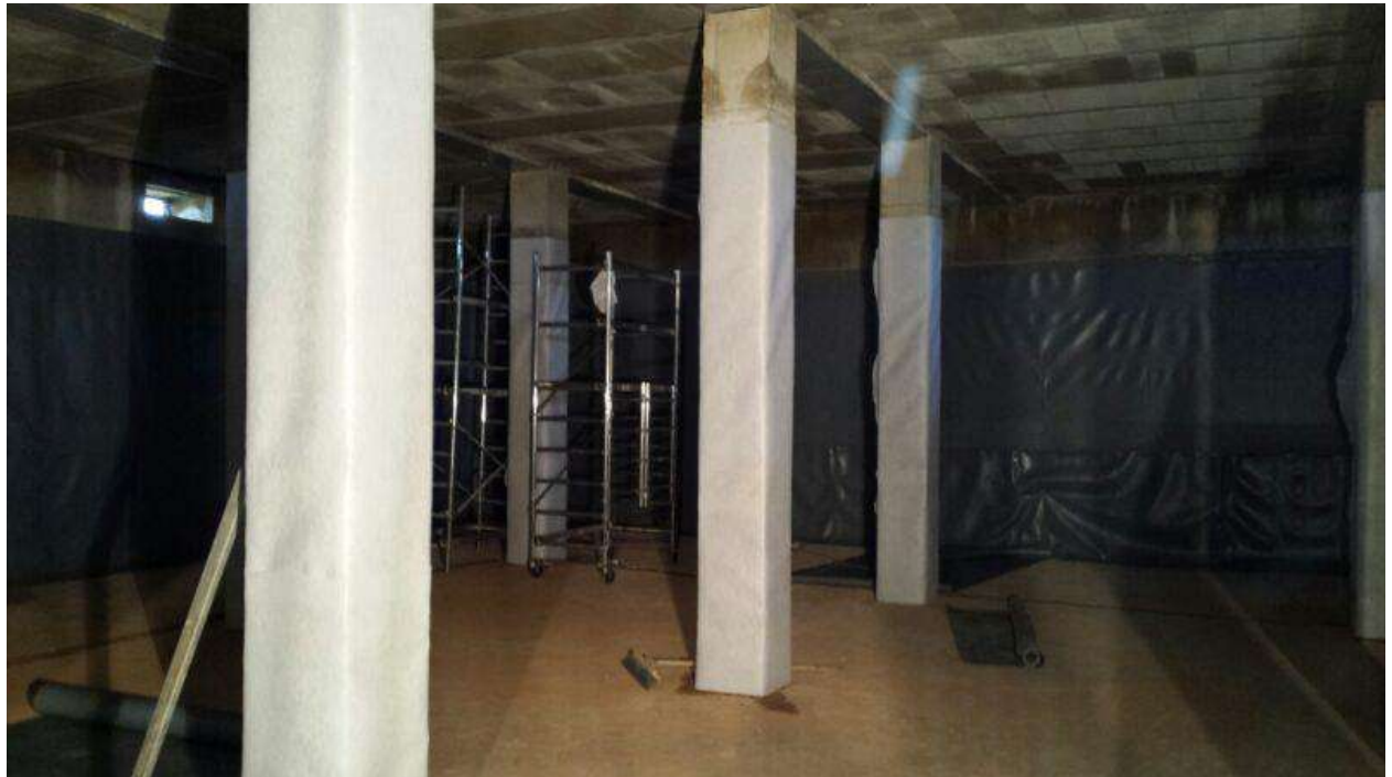
GEOTEXTIL PILARES
