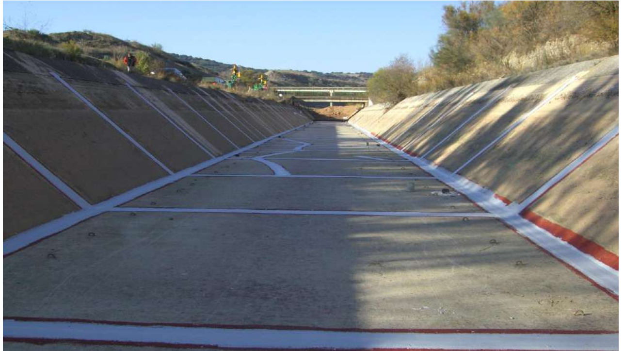
CANAL DE LODOSA
