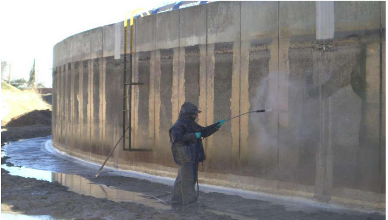
LIMPIEZA DE JUNTAS
