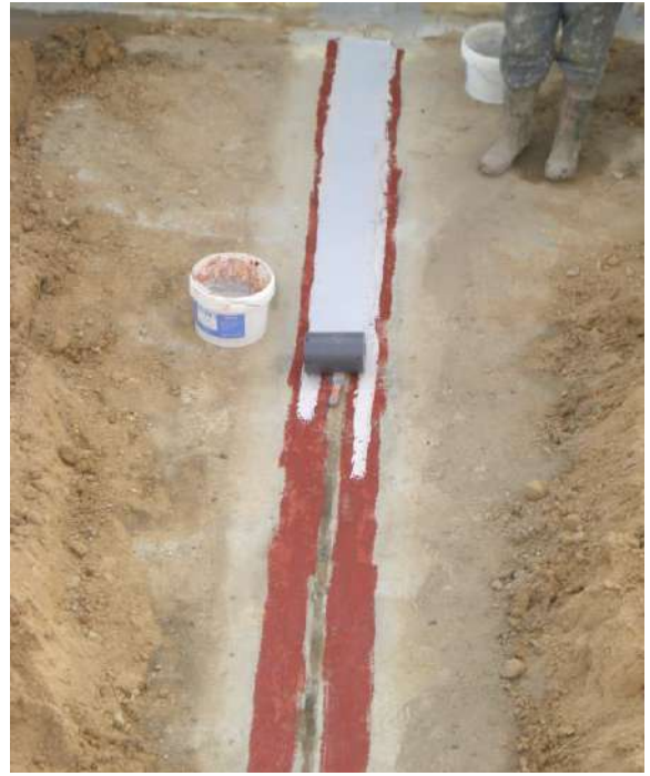
EJECUCION JUNTA PVC
