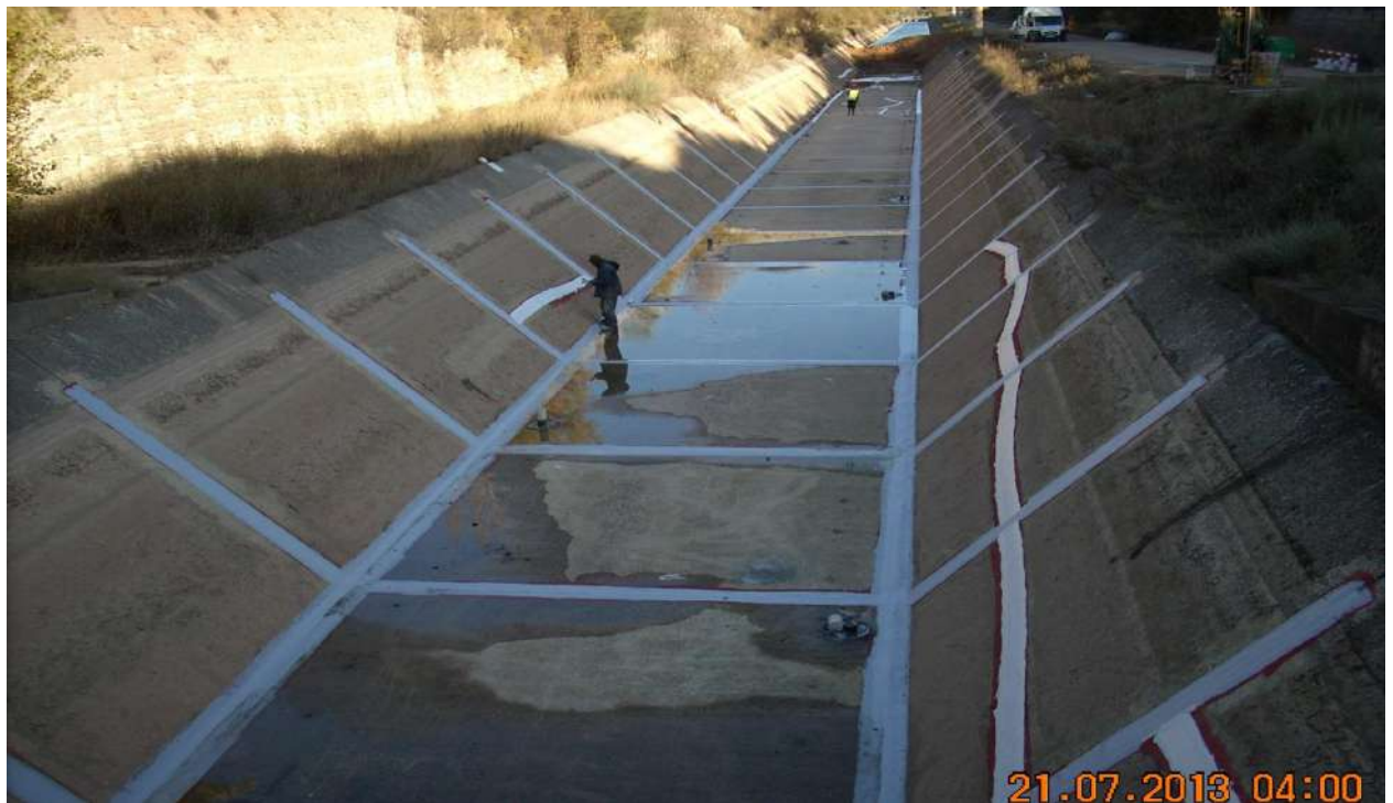
CANAL DE LODOSA
